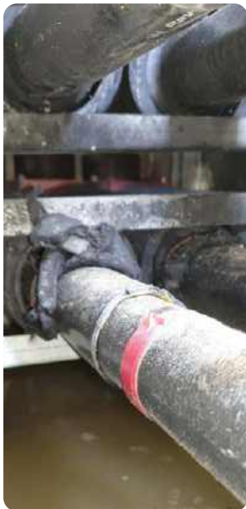
Figuur 13: Water in het keldercompartiment (bron: Enexis).
